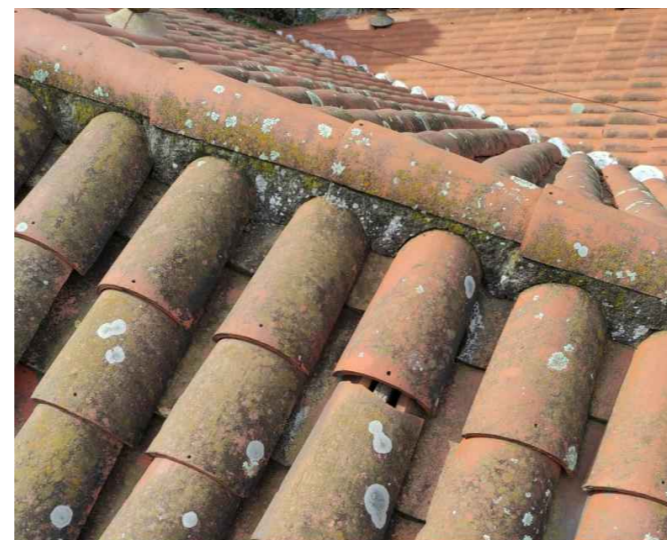
Tejas rotas a reemplazar.
