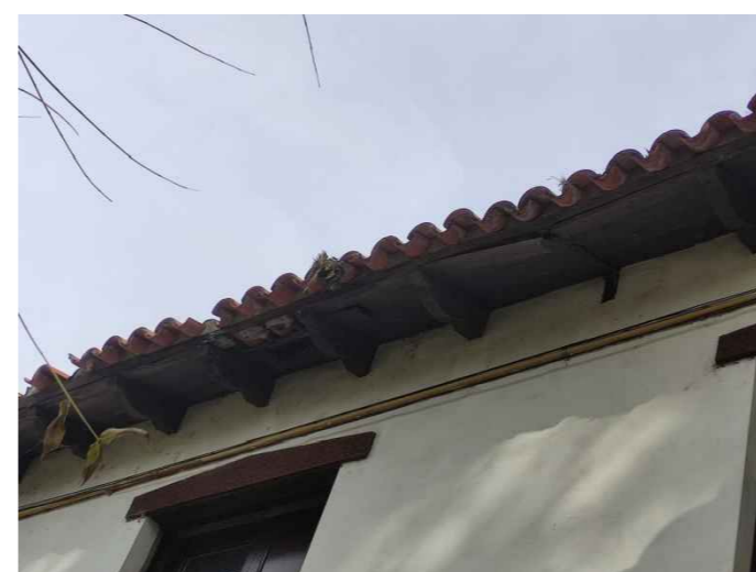
Reemplazo de entablados y limpieza de tejas
