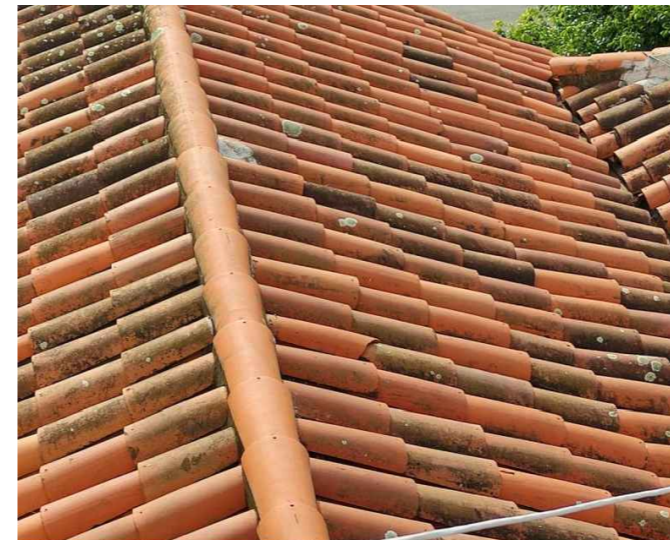
Tejas rotas a reemplazar.
